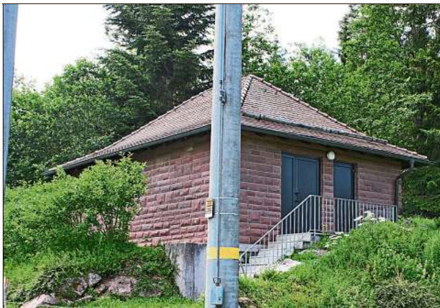
Umwidmung, Innenausbau und Benutzung des früheren Wasser-Hochbehälters durch Herzogenweiler ist für den Ortschaftsrat mittelfristig ein wichtiges Projekt. Foto: Zimmermann
