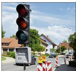
Der Verkehr auf der Ortsdurchfahrt wird per Ampel an der Baustelle für den Minikreisverkehr vorbeigeleitet. Fotos: Kaletta
