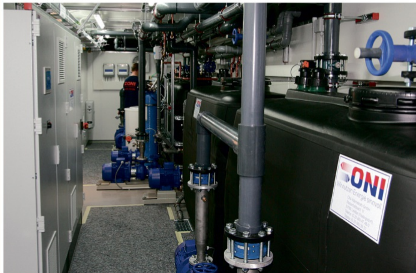
Blick in die energieoptimierte Containerkühlanlage der Hans Huonker GmbH.
