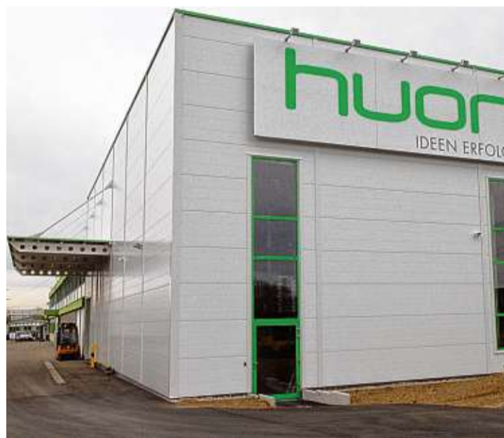
Ein imposantes Gebäude ist das neue Schieberegallager der Huonker GmbH in Marbach, das im Dezember 2014 fertig gestellt wurde. BILDER: RÜDIGER FEIN
